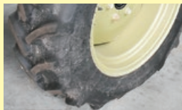
亀裂や摩耗、ボルトの緩み、 空気圧の確認。
